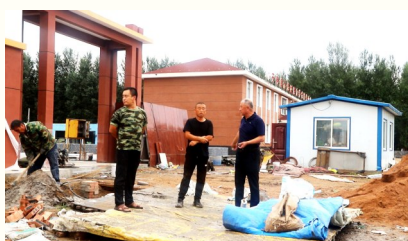
官营子村幼儿园施工现场
